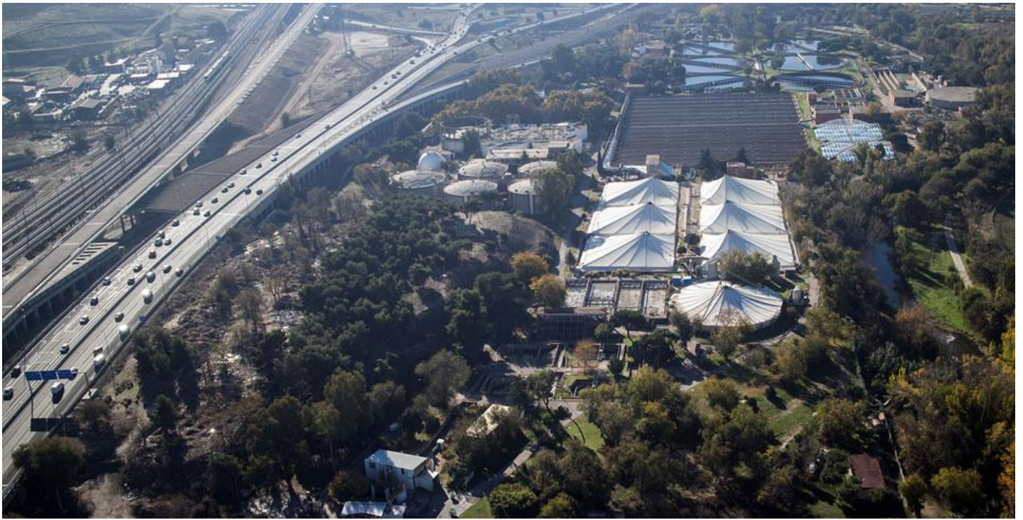
Estación Depuradora de Aguas Residuales (EDAR) La China
