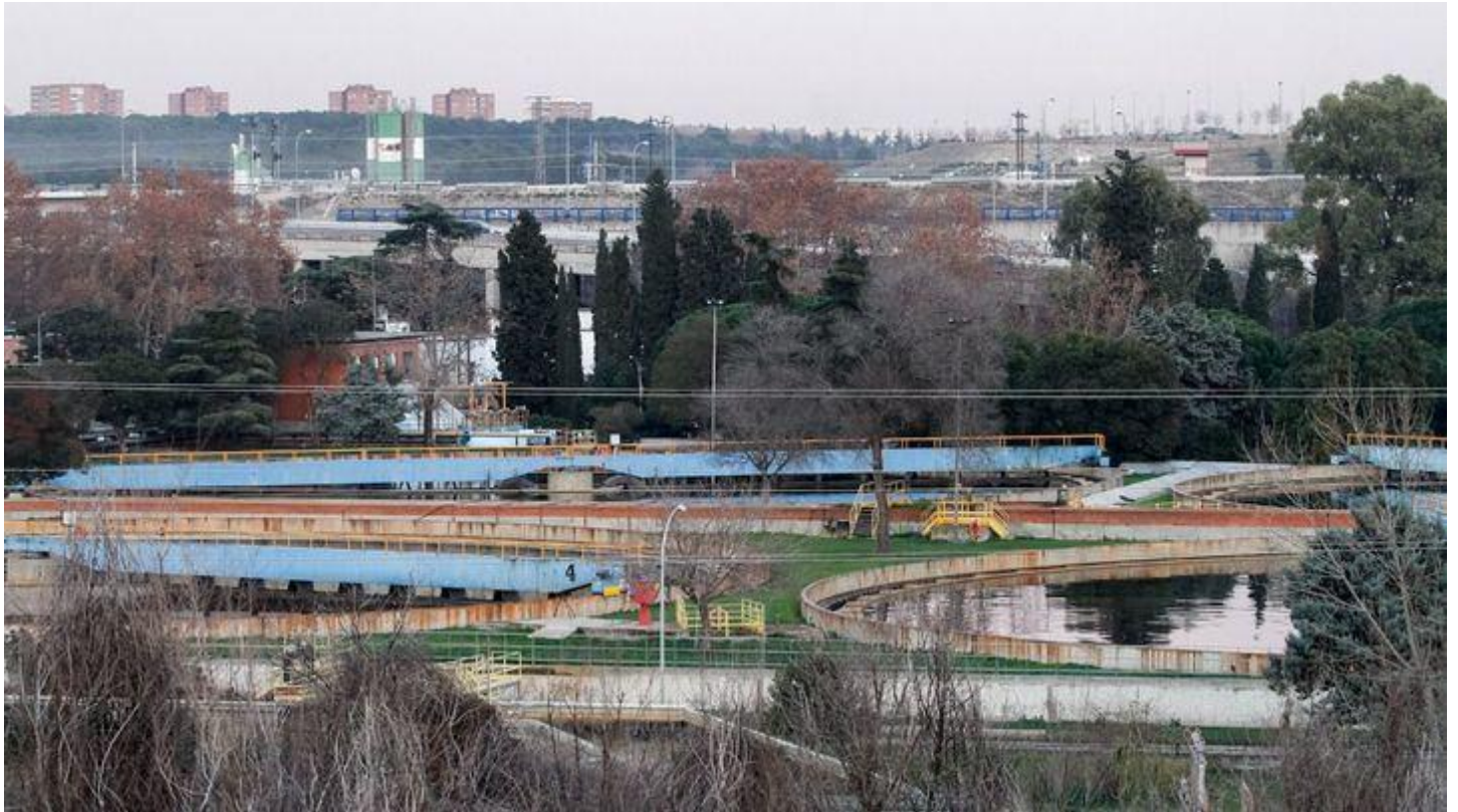
Decantadores de la depuradora de La China. KIKE RINCÓN
