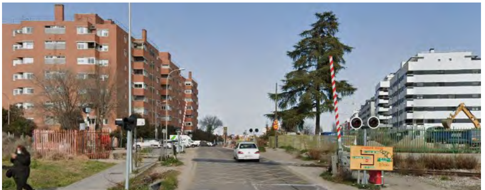
Paso a nivel en calle Eduardo Barreiros antes de las obras de ampliación
